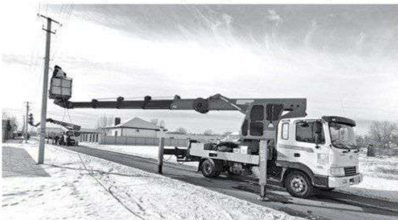
Чтобы ускорить процесс модернизации уличного освещения, параллельно работают две автовышки
